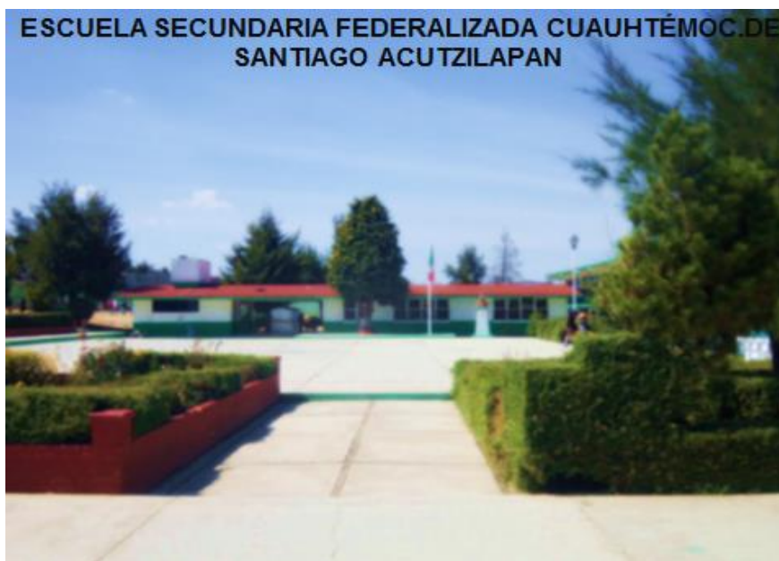
Figura 1. Vista frontal de la Escuela Secundaria Cuauhtémoc
